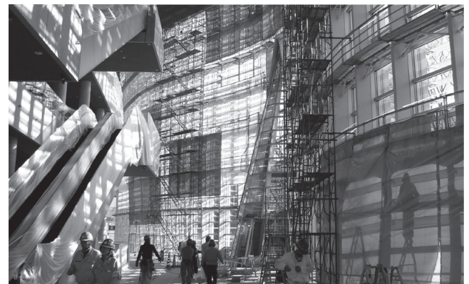
写真-1 都内美術館での「フミンコーティング」施工の様子
