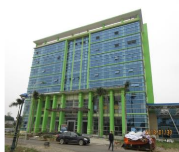
EMTC ハノイ（建設中）
