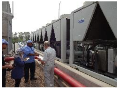
印刷工場のヒートポンプ
