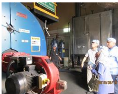
ボイラー調査
