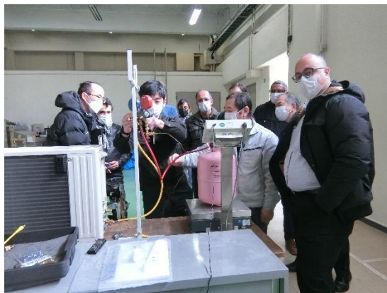
室外機及び室内機設置と漏洩チェックの実習
